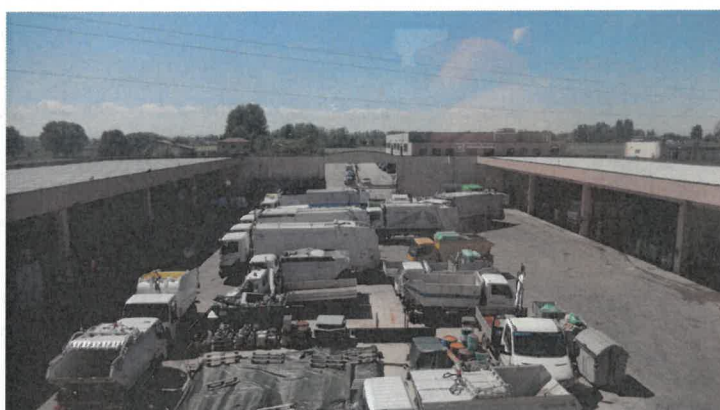
PIAZZALE INTERNO E RETROSTANTE LA PALAZZINA UFFICI
