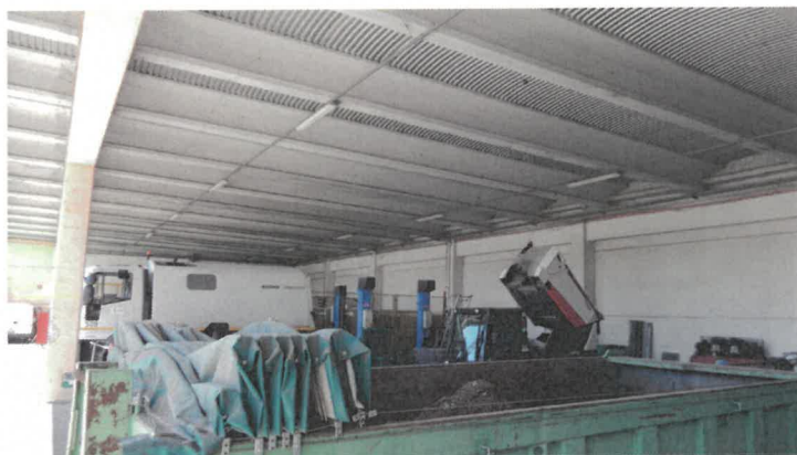
DEPOSITO IN SOTTO-TETTOIA (LATO EST) PROSPICIENTE PIAZZALE INTERNO
