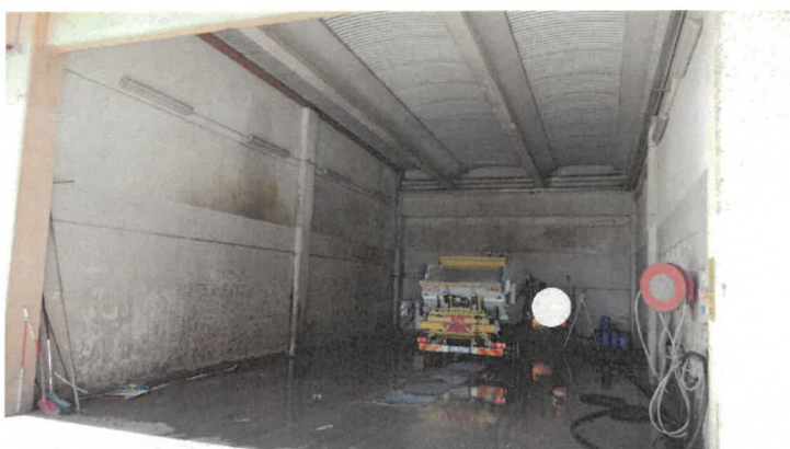
ZONA LAVAGGIO AUTOMEZZI (LATO OVEST) ADIACENTE MAGAZZINO RICAMBI
