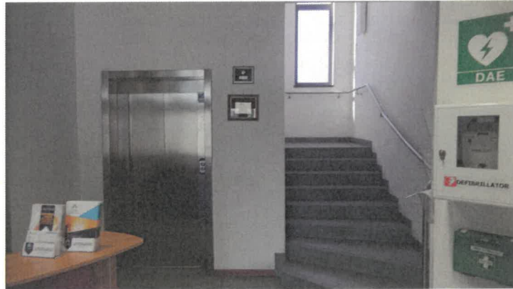
ATRIO INGRESSO VERSO ELEVATORE E SCALA (1 DI 2)
