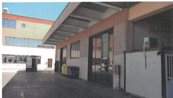
DEPOSITO /MAGAZZINO (LATO EST) PROSPICIENTE PIAZZALE INTERNO
