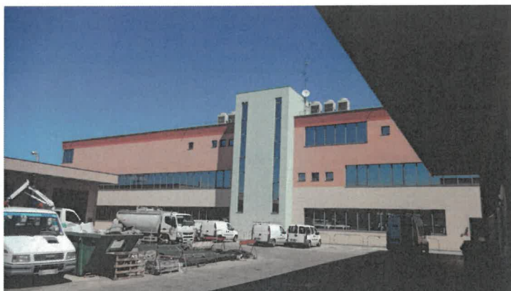
PROSPETTO SUD PALAZZINA UFFICI PROSPICIENTE PIAZZALE INTERNO RETROSTANTE
