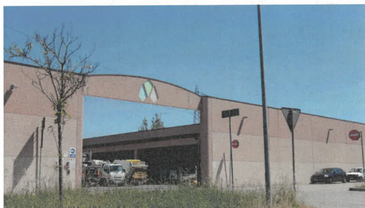
ACCESSO SUD AL PIAZZALE INTERNO (ZONA MAGAZZINI RETROSTANTI)
