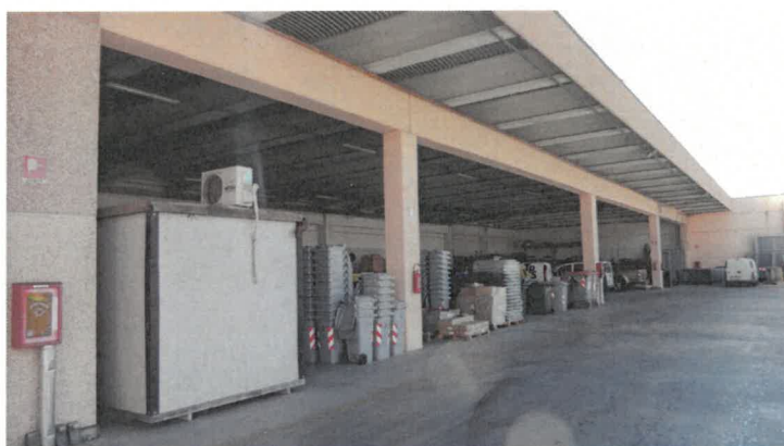
DEPOSITO IN SOTTO-TETTOIA (LATO OVEST) PROSPICIENTE PIAZZALE INTERNO
